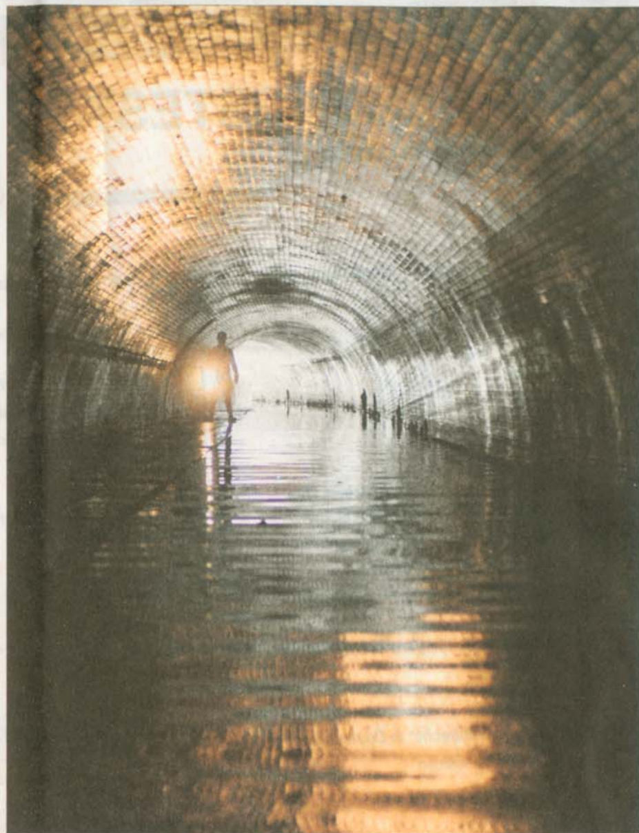
Das Kuhmühlenstammsiel wurde 1902 nach Plänen des Engländers William Lindley erbaut. Wenn es stark und lange regnet, füllt sich das Siel bis unter die Decke.
