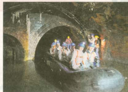
Beim Pumpwerk Hafensstraße endet unsere Fahrt. Von hier aus wird das Wasser unter die Elbe ins Klärwerk geleitet.
