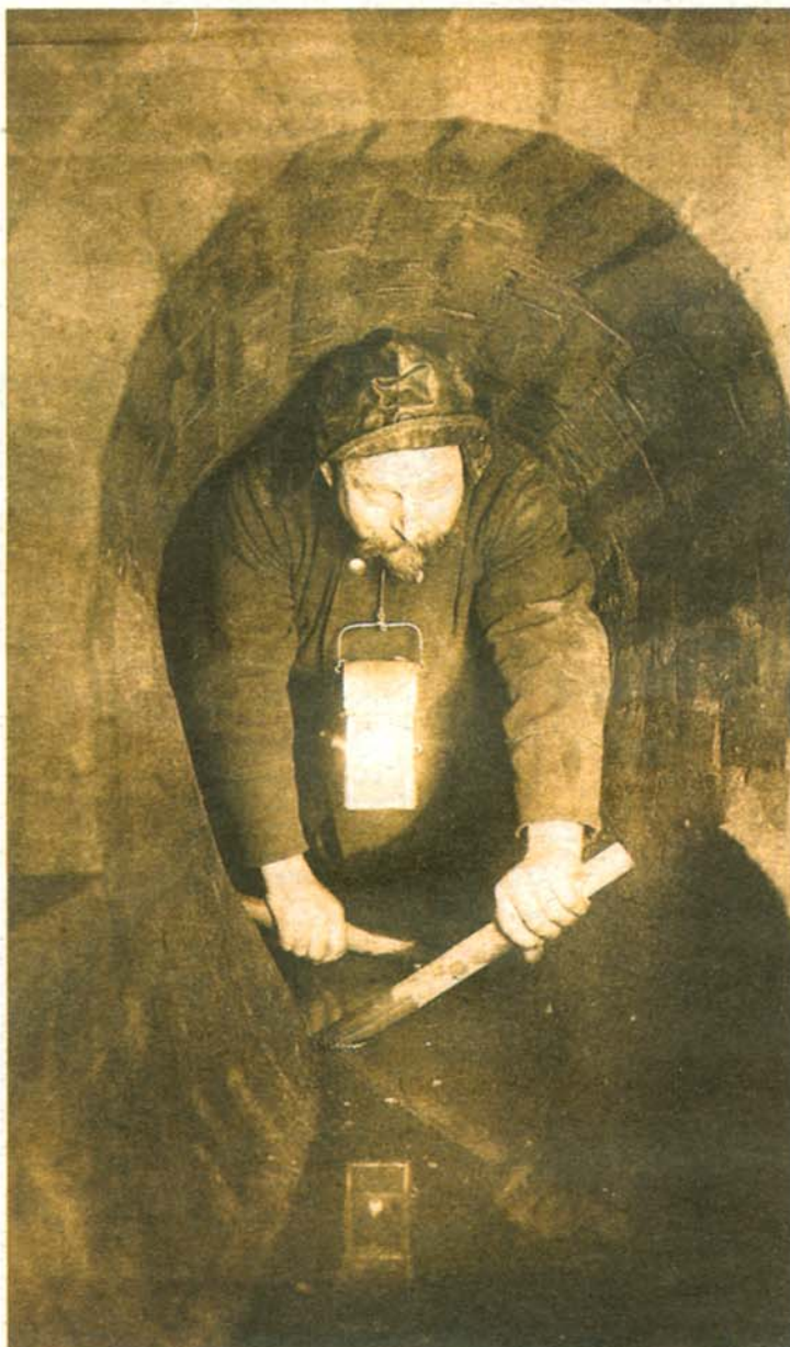
Ziemlich eng, aber perfekt geplant: Eine Inspektion des Hamburger Abwassersystems um 1900.
